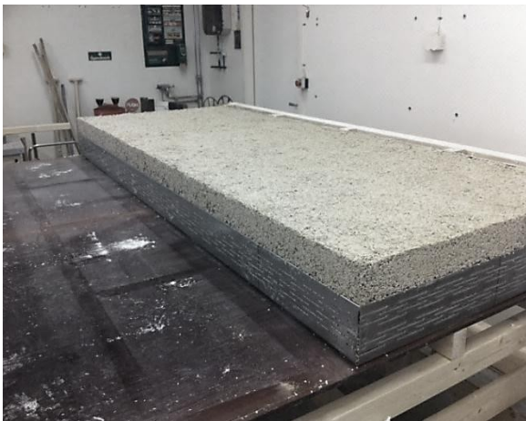
Figur 18. Färdig vägg efter 2 dygn.
