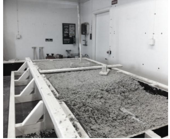
Figur 17. Gjutningen i slutskedet. Stålstommen är nästan helt täckt.
