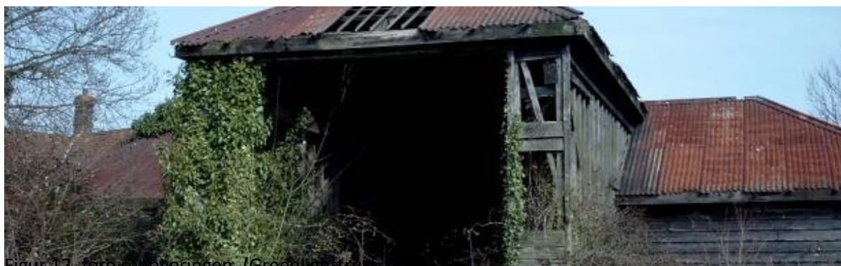
Figur 12. före renoveringen. (Greenlighttrust, 2013)
