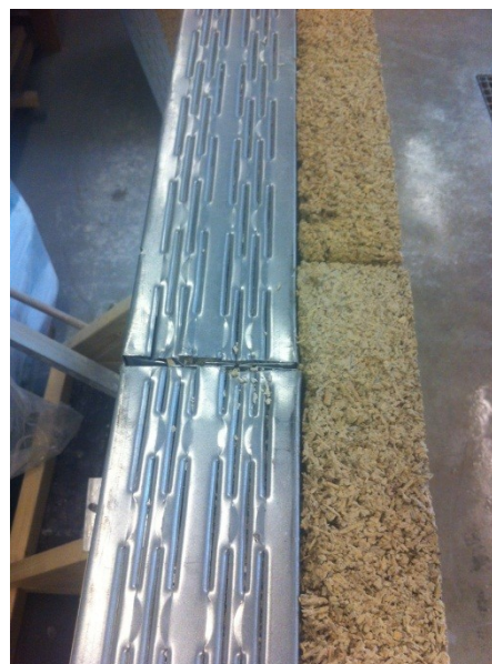
Figur 28. Sammanfogning av väggelement med överlappning
