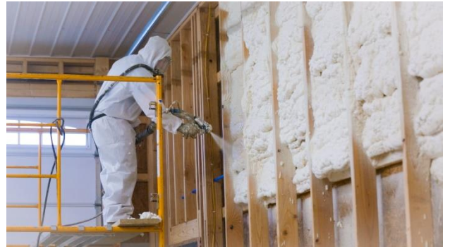
Figur 4.6 Polyuretan i skumform. Proconizo.Az, (2024).
