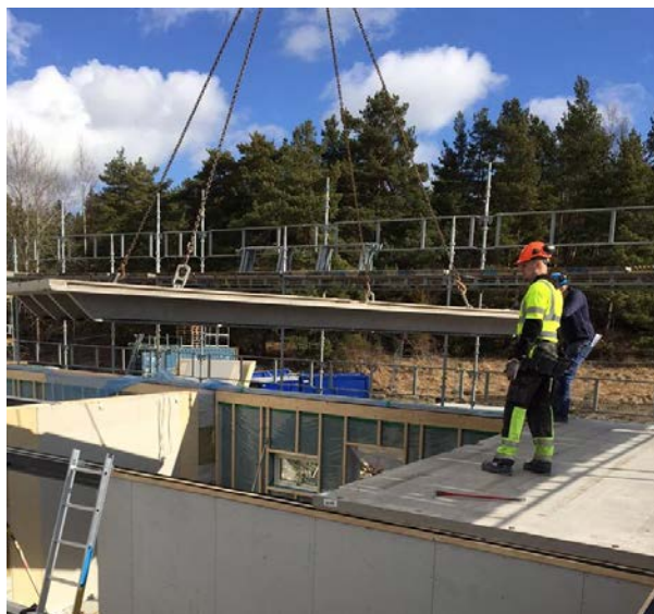
Bild 2 Montering av betongbjälklag
