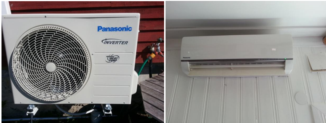
Figur 1. Bilden visar en luftvärmepump. Till vänster synes utomhusaggregatet och till höger visas inomhusaggregatet.
