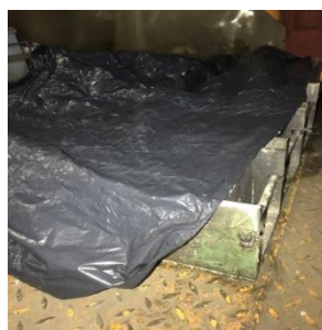
Bild 4.2.4.1a Plastad betong
