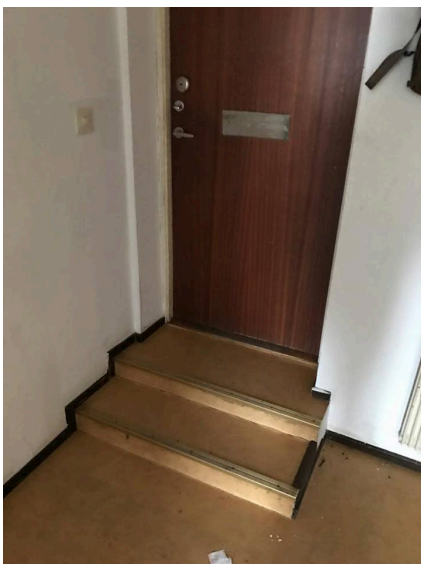
Figur 6. Nivåskillnad mellan tidigare butiksverksamhet och trapphus. Egen bild.
