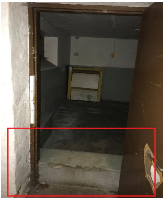
Figur 7. Klack vid entré till tvättstuga är markerat i rött. Egen bild.
